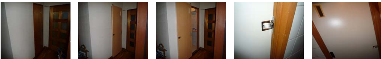
M病院 託児所改修工事(美濃市 保育施設) H.24.06 木製建具工事
