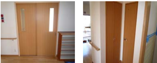
乘里公民館 新築工事(可児市 公共工事) H23.03 木製建具工事
