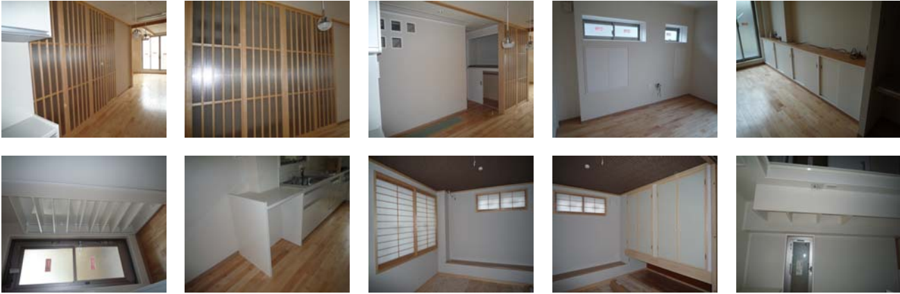
T社 事務所 新築工事(加茂郡坂祝町 事務所) H.24.06 木製建具・木製家具工事
