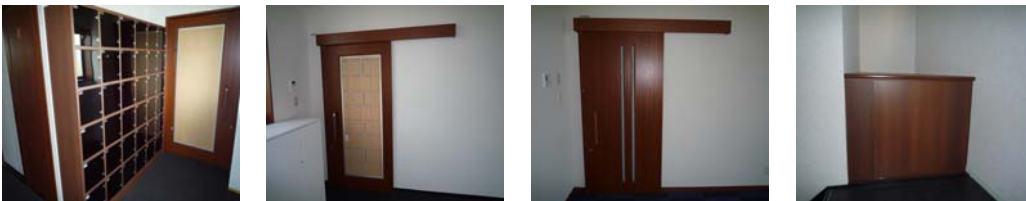
K邸 リフォーム工事(関市 個人住宅) H.24.06 木製建具工事
