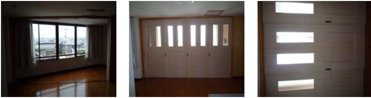
Y邸 新築工事(愛知県名古屋市熱田区 個人住宅) H23.05 木製建具・木製家具工事
